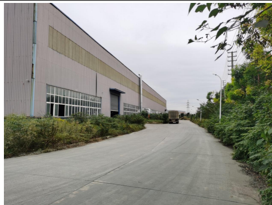
照片 6: 厂区绿化现状
