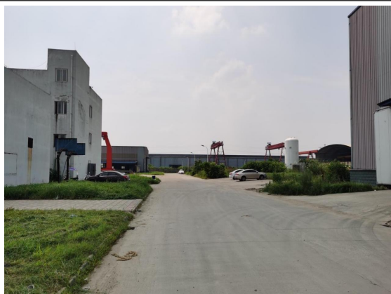
照片 5: 厂区绿化现状
