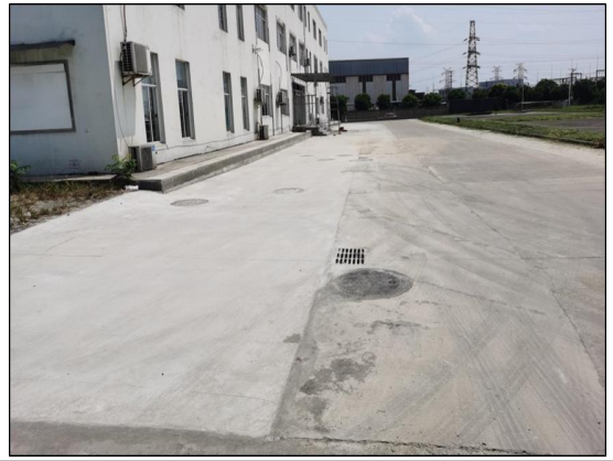
照片 2: 厂区硬化现状
