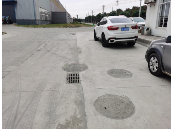
照片 3: 厂区排水设施现状
