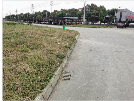
照片 4: 厂区排水设施现状
