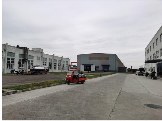
照片 1: 厂区硬化现状
